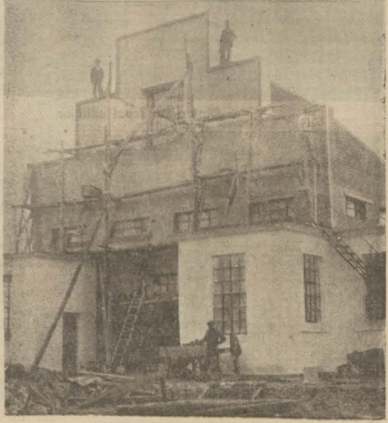
Kırkağaç elektrik fabrikasının inşaatından bir görünüş
